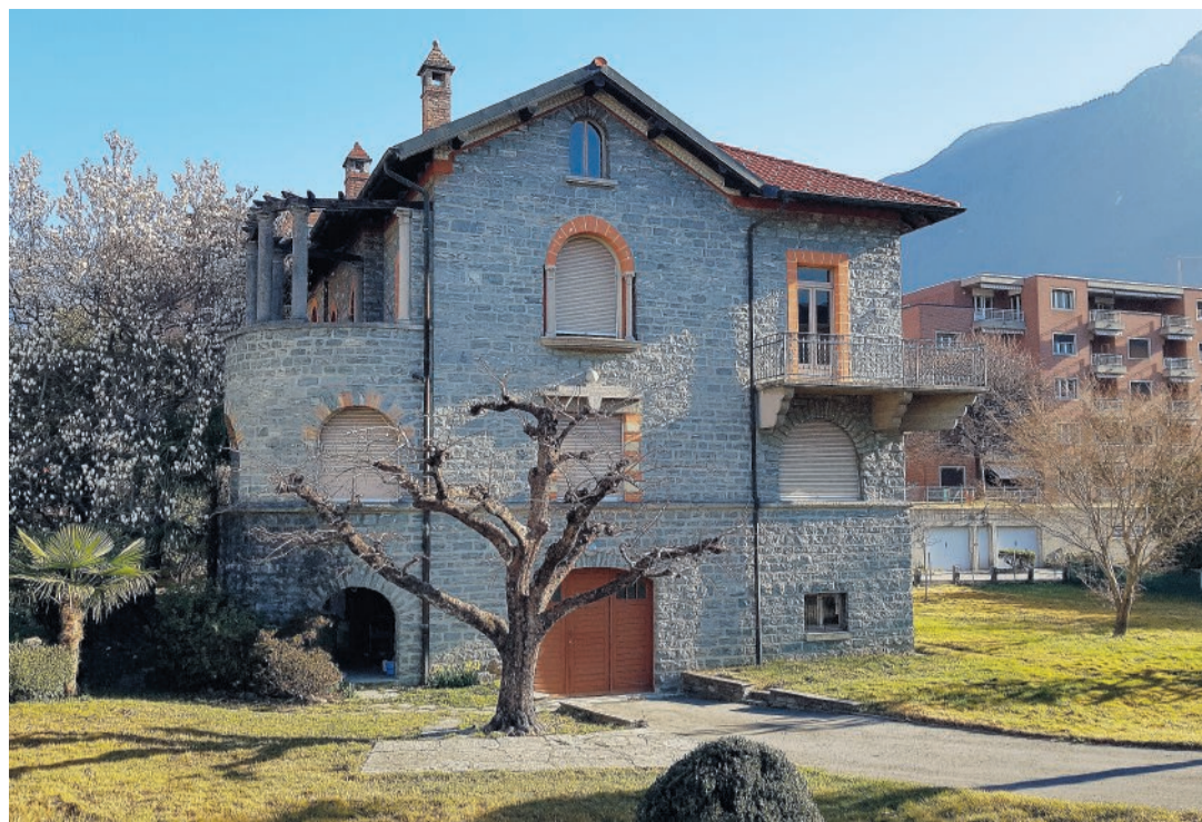
Una villa con ampi locali interni e un grande giardino: presto la presentazione pubblica
